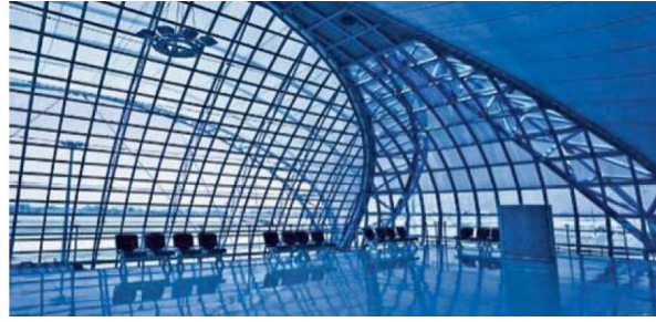
Şekil 18. Bangkok Terminal Binası: Dünyanın En Büyük Işınım Isıtma Sistemi [30].
